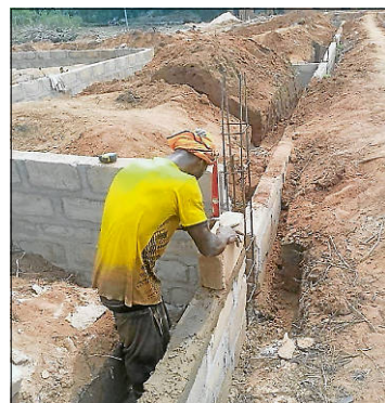
Bau des Fundaments für die kleine Klinik in Nigeria.
