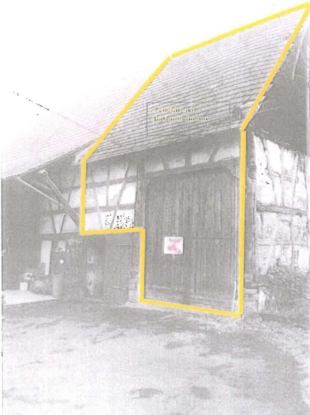
Abbildung 1: Scheune BESTAND – Ansicht Hofseite – WEST-Seite
